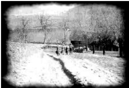
Drogę na teren budowy nowej szkoły zbudowano zasypując ziemią głęboki wąwóz.
