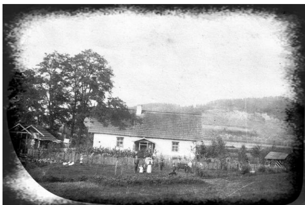
Budynek szkolny z r. 1886.
